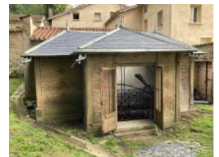
L'extérieur après restauration
