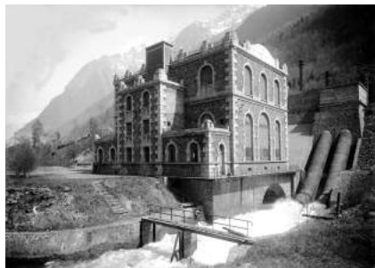
La centrale hydroélectrique des Vernes
