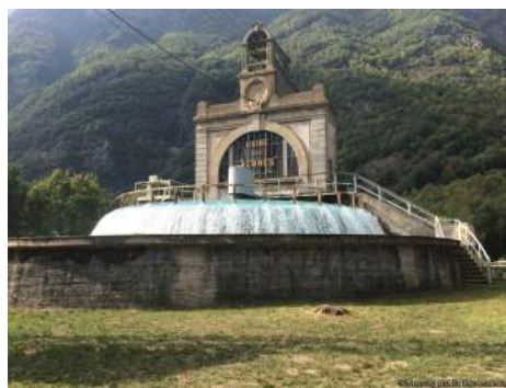
La centrale hydroélectrique des Vernes
