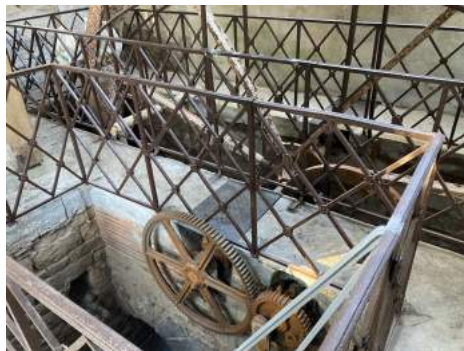
Intérieur du bâtiment
